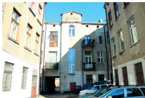
Zdj. 20. Elewacja tylna – Mickiewicza 7, Brzeziny (archiwum autora)
