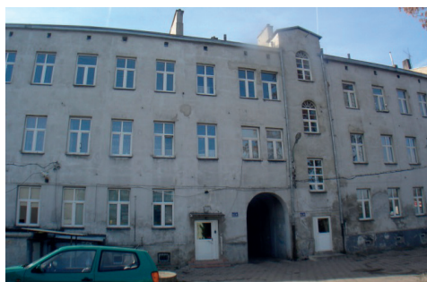
Zdj. 22. Elewacja tylna – Mickiewicza 22, Brzeziny (archiwum autora)
