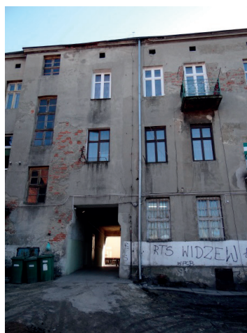
Zdj. 8. Elewacja tylna kamienicy – Kościuszki 2, Brzeziny (archiwum autora)
