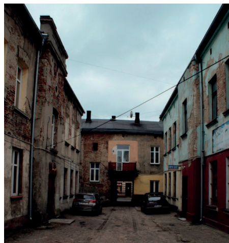
Zdj. 4. Elewacja tylna kamienicy- św. Anny 13, Brzeziny
