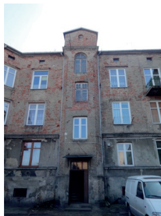
Zdj. 10. Elewacja tylna- Mickiewicza 10, Brzeziny (archiwum autora)
