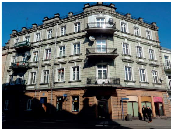
Zdj. 9. Kamienica narożna - Mickiewicza 10, Brzeziny (archiwum autora)
